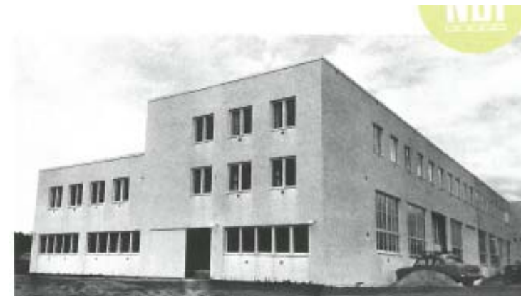
NBIs prøvehus på Ås (Huset hadde 60 veggfelt) og nye lokaler i Trondheim
